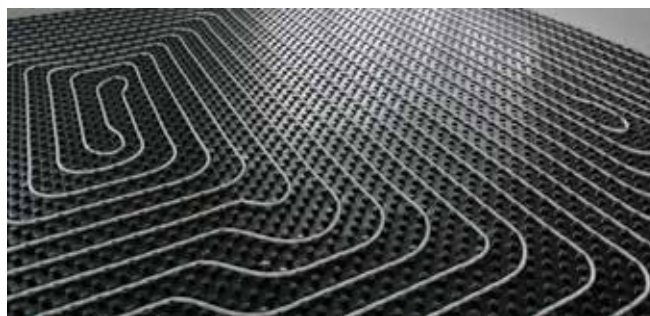
Рисунок 9: Укладка труб для теплого пола
